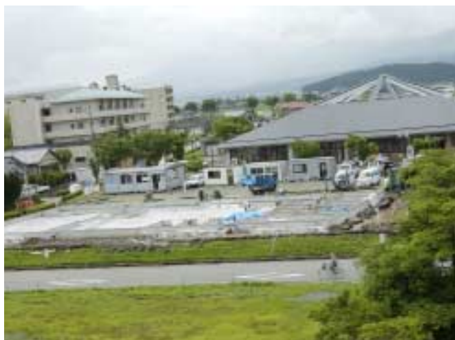
総合センター内に建設中の内牧支所
