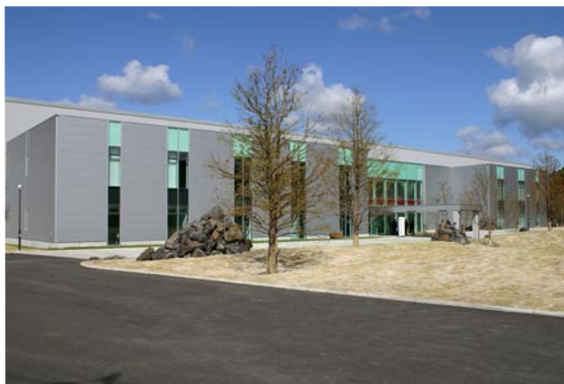
▲赤水(国道57号沿い)に完成したエム・テクニク(株)阿蘇工場
