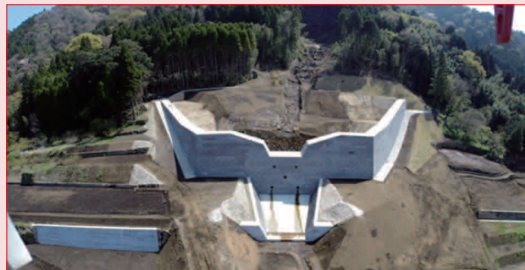
東手野川2砂防堰堤（3月完成）
