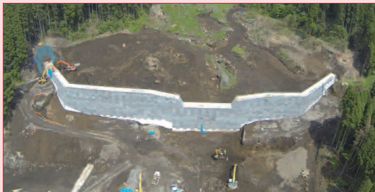
坂梨砂防堰堤（7月完成予定）
