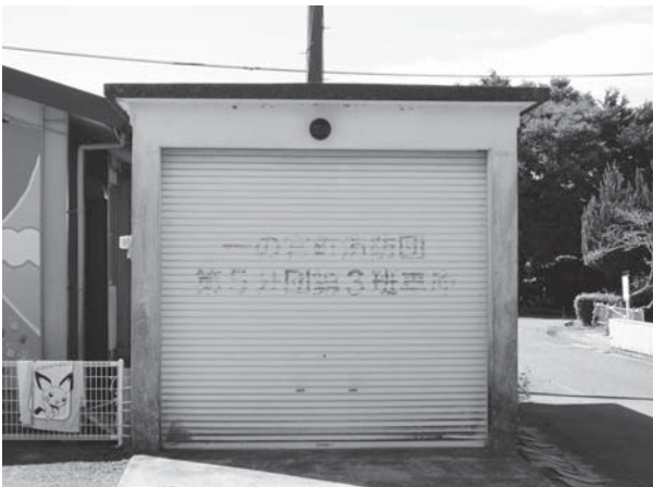
中通の移転対象ポンプ小屋
