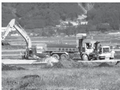
造成中の一の宮中グラウンド
