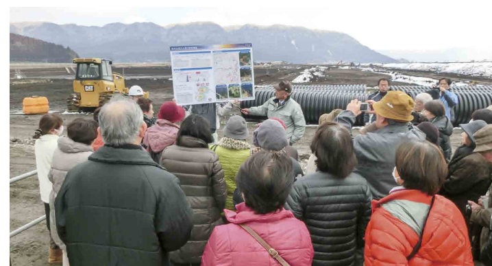
小倉遊水地工事現場。大規模な工事に驚く参加者。
