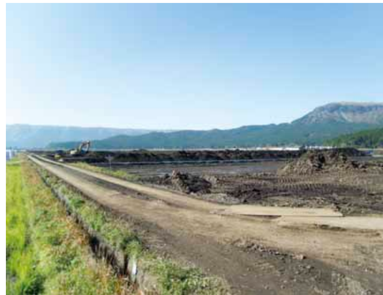
工事が進められている小倉遊水地の工事現場
