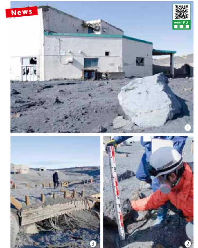
①ロープウェイ駅舎付近に落ちた噴石。駅舎内の損傷も激しく、外壁や屋根にも被害が及んでいた。
