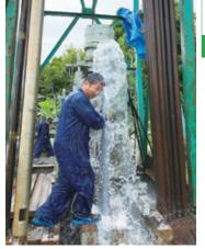
掘削後、仕上げにパイプを入れ て水が湧いたところ。地下水が 無事に噴出した瞬間に安堵。
