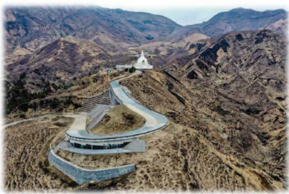
修復された市道仙酔峡線
