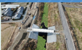
③ 宮原川の改修に伴う黒橋の架替
