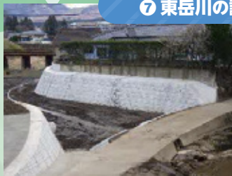
⑦ 東岳川の護岸工事
