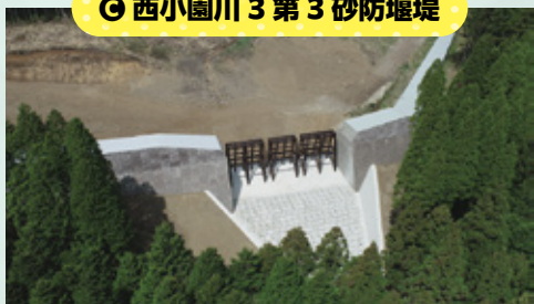
㉔ 西小園川3 第3砂防堰堤
