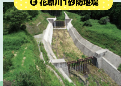
㉖ 花原川1砂防堰堤
