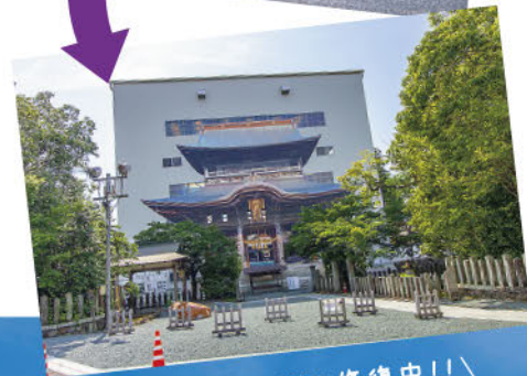
/ 楼門も修復中!! \
