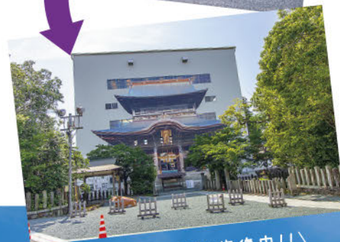
/ 楼門も修復中!! \
