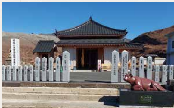
明治23年、阿蘇山上の旧本堂近くに「西巖殿寺奥の院」が建てられます。熊本地震や噴火で被災しましたが、再建されました。
